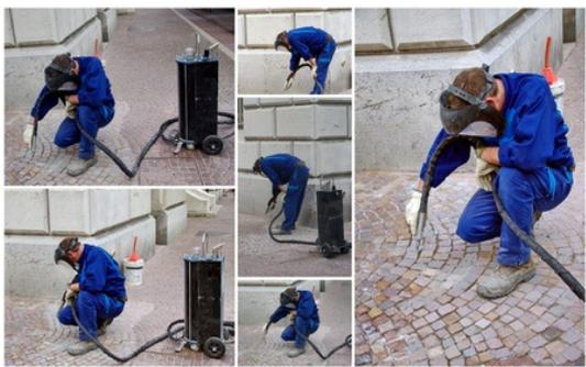
**Sandstrahlen** Das Sandstrahlen wird im Wesentlichen dazu benutzt um groben und losen Schmutz (beispielsweise Rost oder alte Lackschichten) von verschiedensten Oberflächen zu entfernen. So findet das Sandstrahlen auch bei der Restauration von Oldtimern, Denkmälern oder Produktionsmaschinen große Anwendung. Eingesetzt
